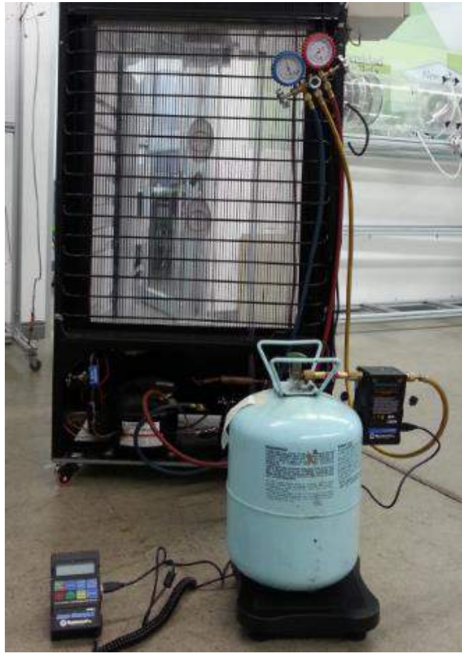
Figura 46. Proceso de carga de refrigerante
