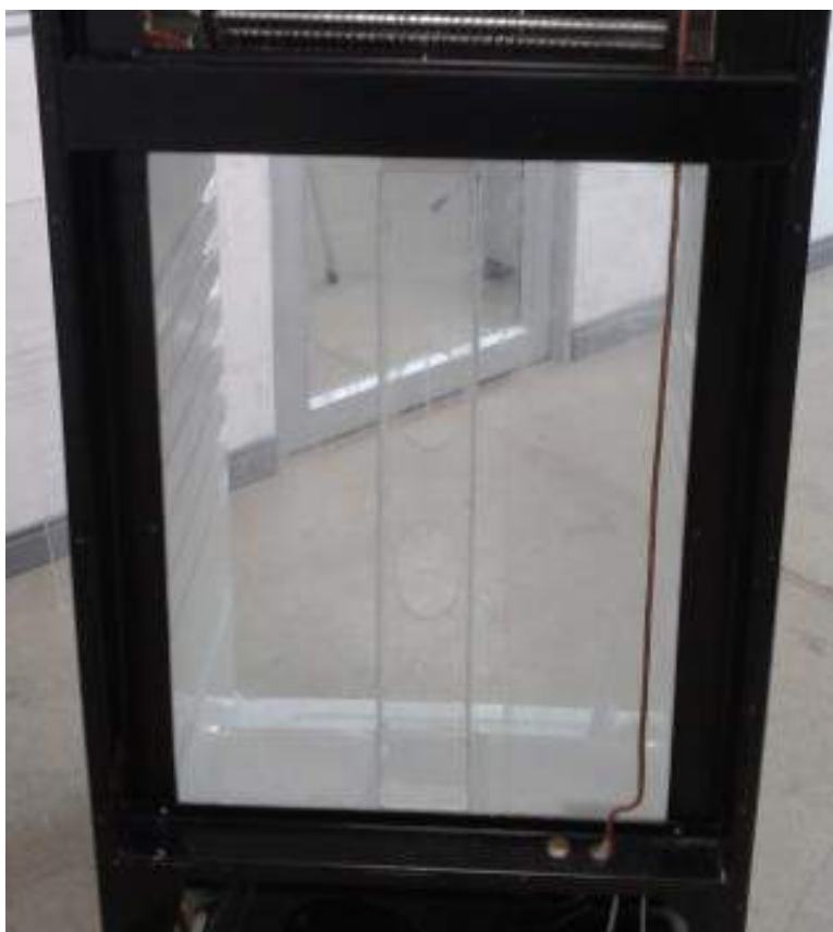
Figura 40. Instalación de ductos del conservador. Hecha por los autores.
