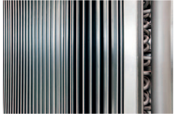
Figura 3: Primer plano de un eliminador de gotitas y un cabezal de serpentín
