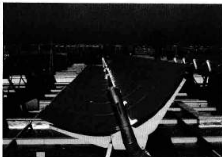
Fig. 24.- Al acabar el día, los colectores cilindro-parabólicos de eje polar deben volver a la posición Este. A la derecha campo de colectores cilindro-parabólicos.
