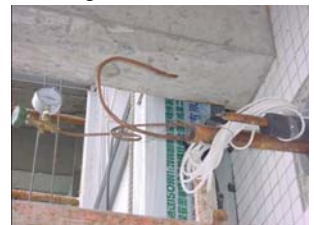
Un ejemplo de la prueba de hermeticidad del aire
