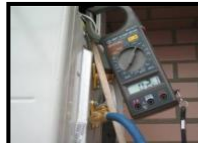
Verificacion : Presion, Voltage, Corriente y diferencia de temperaturas
