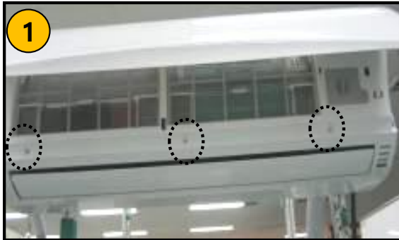
Levante la parrilla de entrada y quite los 3 tornillos.
