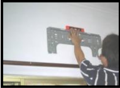
Lugar de Instalacion
