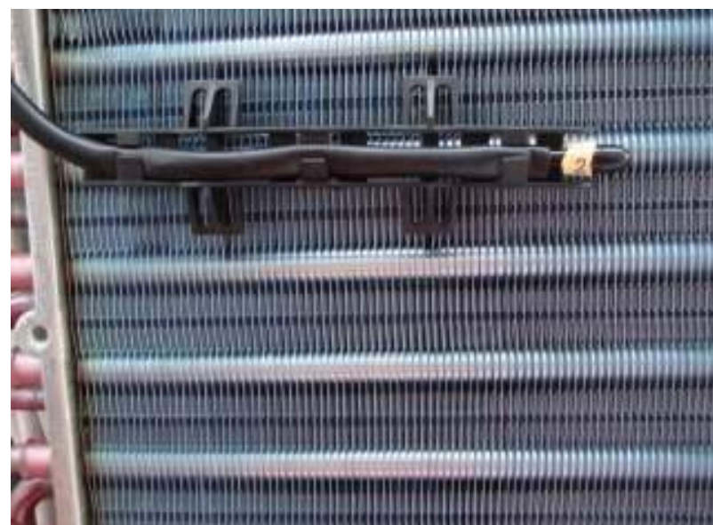
Sensor de Temperatura de Aire
