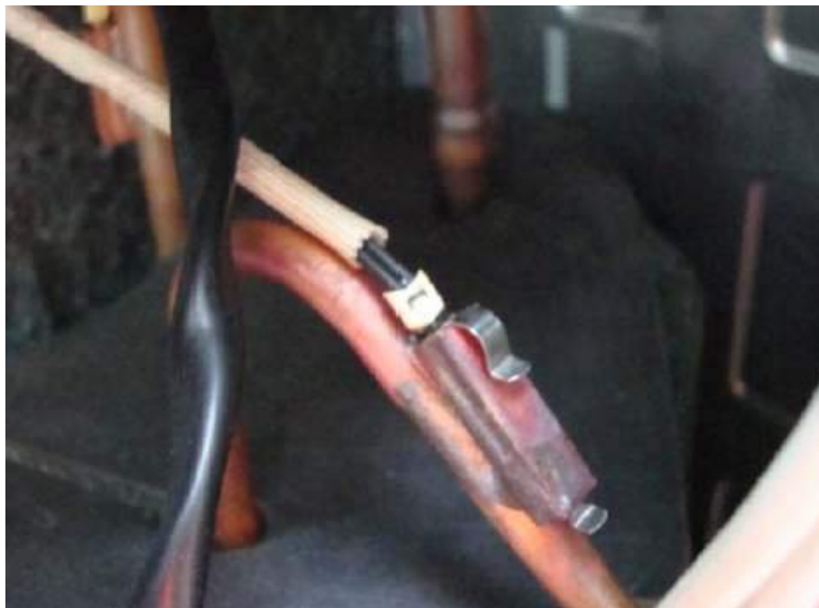
Sensor de Temperatura de Cañería
