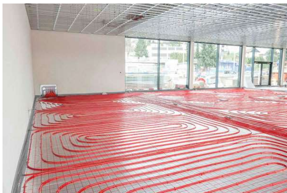
Combinados piso radiante y fan coils
